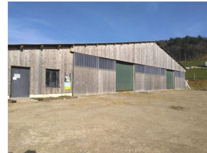
Figure 8 : Photographie de la bergerie
