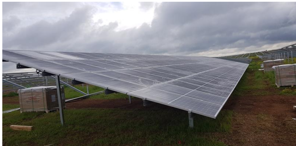
Figure 8 : Installation de modules pour le projet de Bienvenida (ESP)
