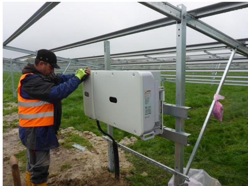
Figure 10 : Fixation d'un onduleur décentralisé
